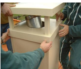
Étape 3 : Mettre le couronnement en place et la manchette en inox dans le conduit. Enlever le papier de protection sur le joint noir. Serrer avec les vis papillon.
