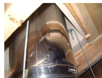
Étape 5 : Passer les tiges filetées dans les anneaux et les profils en U et bloquer sous la charpente.
