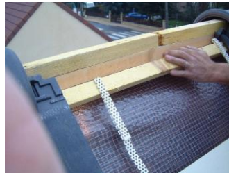
Étape 1 : Pose du solin (axe à 70 cm du faîtage).
