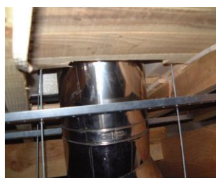
Étape 5 : Passer les tiges filetées dans les anneaux et les profils en U et bloquer sous la charpente.
