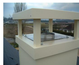
Étape 3 : Mettre le couronnement en place et la manchette en inox dans le conduit. Enlever le papier de protection sur le joint noir. Serrer avec les vis papillon.
