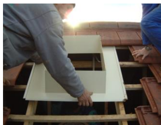
Étape 1 : Pose du solin (axe à 70 cm du faîtage).
