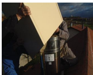
Étape 2a : Passer le fût au dessus du conduit et le positionner dans les fentes du solin.
