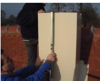
Étape 2b : Mettre le fût de niveau et le bloquer avec les anneaux de serrage.
