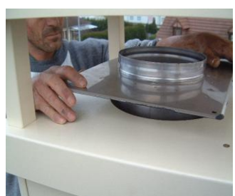
Étape 3 : Mettre le couronnement en place et la manchette en inox dans le conduit. Enlever le papier de protection sur le joint noir. Serrer avec les vis papillon.
