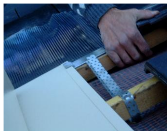
Étape 4 : Glisser la bavette dans le bas du solin et la fixer avec les bretelles.
