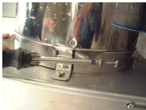
4) Bloquer le té de branchement sur la console par serrage de la bride de sécurité.
