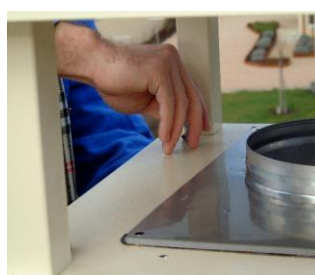
Étape 3 : Mettre le couronnement en place et la manchette en inox dans le conduit. Enlever le papier de protection sur le joint noir. Serrer avec les vis papillon.
