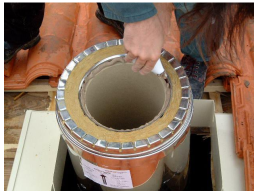
6) Mettre un cordon de colle sur l'extrémité du tube céramique. Emboîter l'élément suivant et exercer une légère pression.
