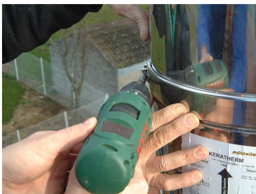
7) Positionner la bride de sécurité et serrer la vis.
