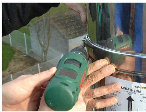
**Mettre un cordon de colle sur l'extrémité du tube céramique, emboîter l'élément suivant et exercer une légère pression. Serrer la bride de sécurité et répéter ces opérations jusqu'en haut du conduit.**
